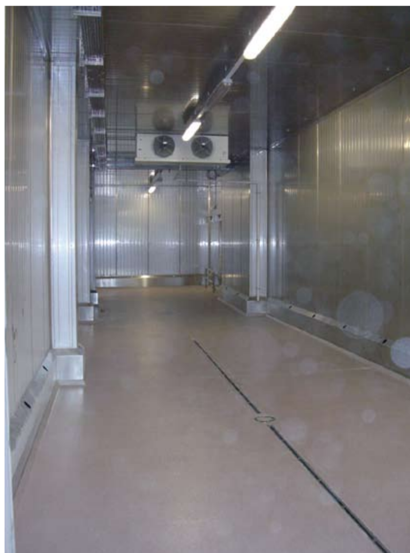
Egal ob Neubau oder Sanierung eine Frage stellt sich auf jeden Fall: Welches ist das richtige Bodensystem für Fleischereien? Die Anforderungen sind klar: Langlebig, mechanisch und thermisch hoch belastbar, fugenlos von der Hohlkehle bis zum Ablauf, rutschfest und auf jeden Fall auch leicht zu reinigen
