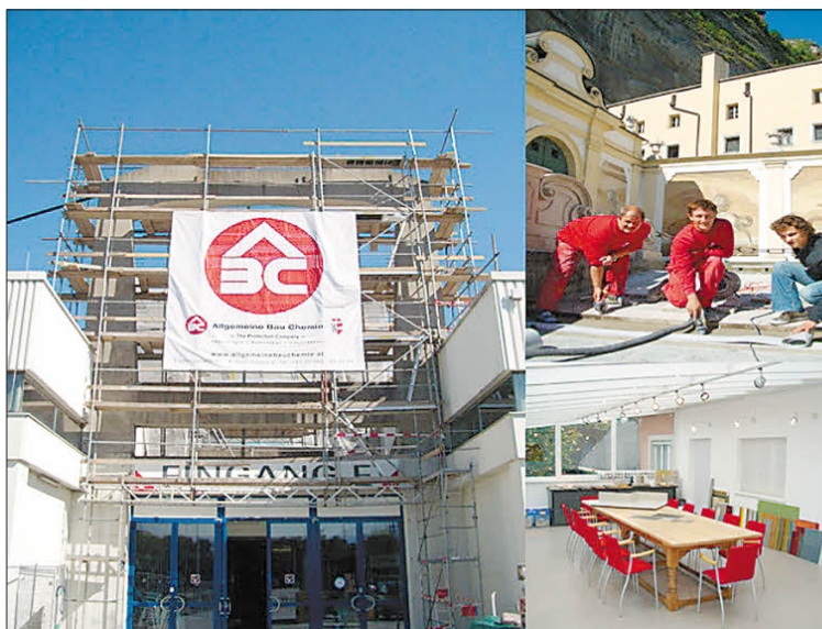
Spezialeinsätze aktuell: Links die Betonsanierung im Messezentrum Salzburg, rechts oben Ausbesserungen der Pferdeschwemme Salzburg, rechts unten der ABC-Schauraum. Bild: SN/ABC
